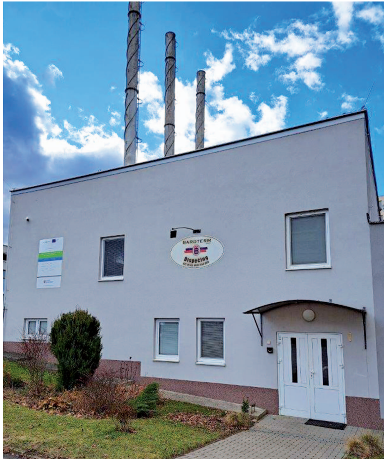
Dispečing na Moyzsovej ulici, z ktorého sa riadi a monitoruje vykurovanie a dodávka tepla a teplej vody. V tomto objekte sa nachádza aj kotolňa K05.
